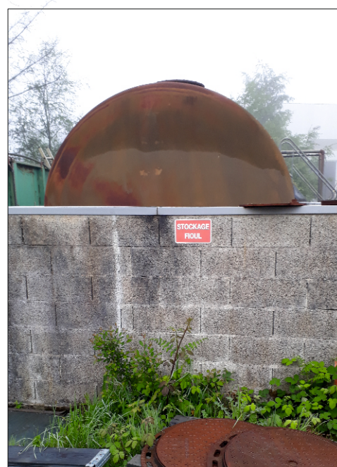
Cuve de carburant sur rétention
